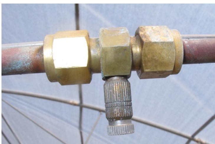
תמונה 4. רכיבים ממערכת צינן התנדפותי. ימין-פומית (דיזה) ערפול בלחץ גבוה, שמאל – מיכל מים, משאבה ולוח פיקוד
