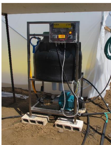
תמונה 4. רכיבים ממערכת צינן התנדפותי. ימין-פומית (דיזה) ערפול בלחץ גבוה, שמאל – מיכל מים, משאבה ולוח פיקוד
