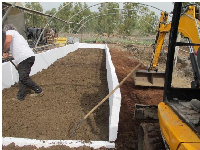
תמונה 1. הכנת ערוגה במילוי קרקע מקומי. ימין – שמירת רווחים בין לוחות הבידוד לצורך ניקוז. שמאל – ערוגה מוכנה לפריסת הצנרת. מילוי עד 10 ס"מ מתחת לרום הסופי
