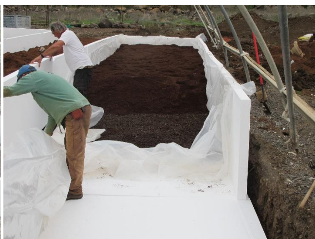
תמונה 2. הכנת ערוגה במילוי מצע גידול. לוחות בידוד צמודים, יריעת פוליאטילן, שכבת טוף גס לניקוז ומצע גידול
