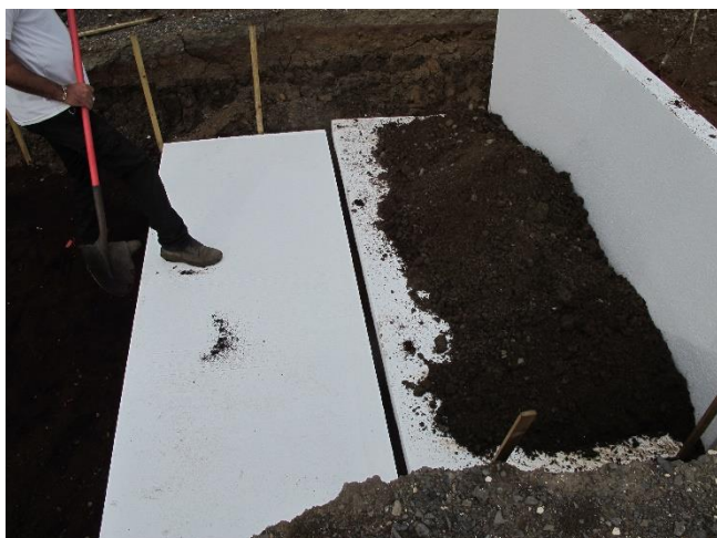
תמונה 1. הכנת ערוגה במילוי קרקע מקומי. ימין – שמירת רווחים בין לוחות הבידוד לצורך ניקוז. שמאל – ערוגה מוכנה לפריסת הצנרת. מילוי עד 10 ס"מ מתחת לרום הסופי
