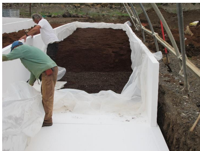
תמונה 2. הכנת ערוגה במילוי מצע גידול. לוחות בידוד צמודים, יריעת פוליאיתילן, שכבת טופ גס לניקוז ומצע גידול
