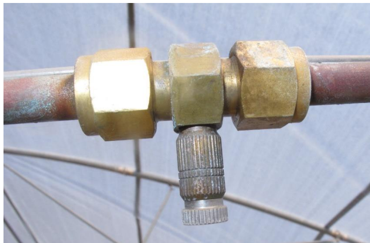
תמונה 4. רכיבים ממערכת צינון התנדפותי. ימין-פומית (דיזה) ערפול בלחץ גבוה, שמאל – מיכל מים, משאבה ולוח פיקוד
