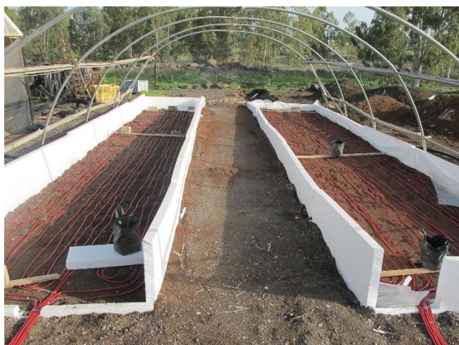
תמונה 3. פריסת צנרת מים בערוגות הניסוי
